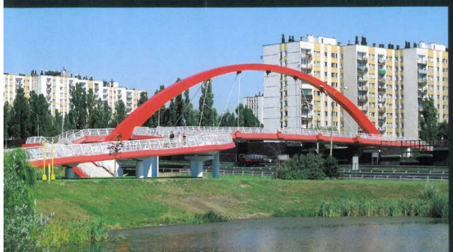
Katowice – kładka dla pieszych nad A4 (Al. Górnośląska)
