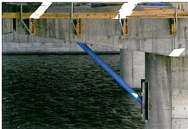
Ryc. 3. Wzmocnienie filaru mostu – lewa jezdnia (kierunek Balice)
