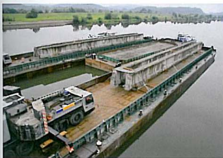
Ryc. 13. Zabezpieczenie dźwigów i belek balastowych na barkach
