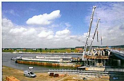
Ryc. 14. Barki w czasie demontażu belek WBS
