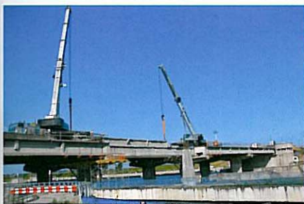
Ryc. 10. Demontaż belek WBS
