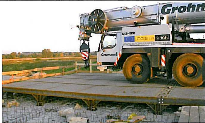
Ryc. 6. Dźwig w trakcie najazdu na platformę
