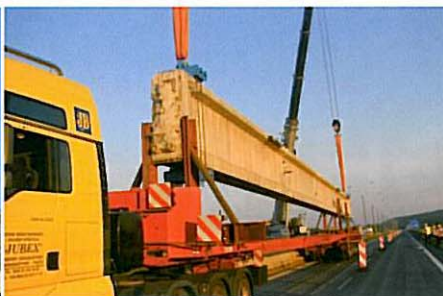
Ryc. 11. Transport dźwigarów WBS
