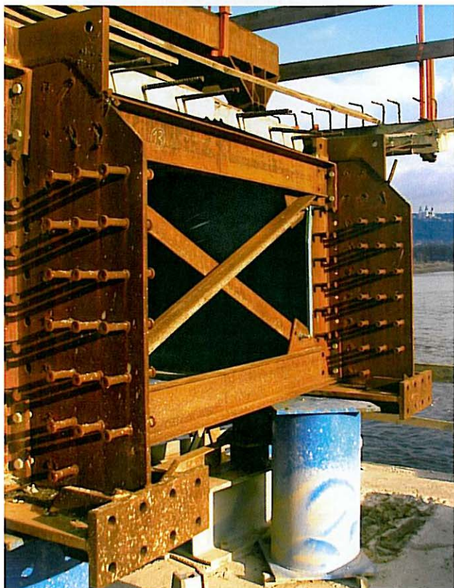
Ryc. 7. Wzmocnienie belek VFT® pod łapy dźwigu
