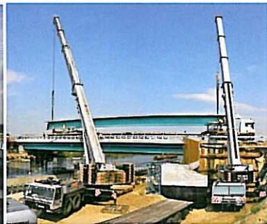
Ryc. 15. Montaż ostatniego przęsła belek VFT
