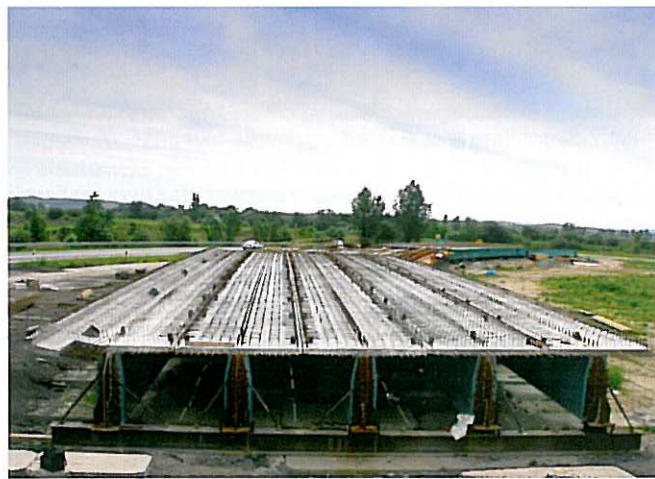
Ryc. 4. Belki VFT® na polu prefabrykacji
