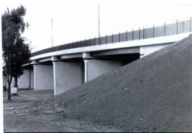
Fot. 2. Wiadukt w ciągu ul. T. Kościuszki w Toruniu
