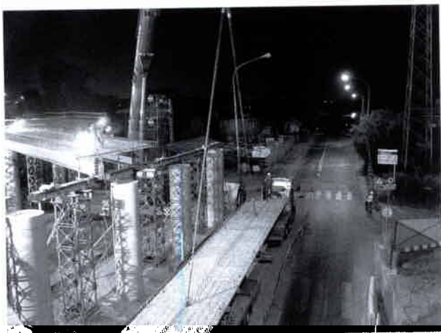
Fot. 1. Remontowany wiadukt północny i południowy w ul. Płowieckiej – B. Czecha w Warszawie
