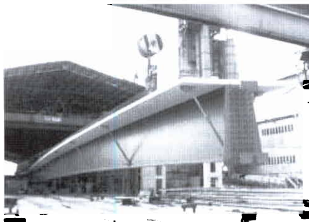
Fot. 1. Wysyłka dźwigarów VFT z wytwórni
