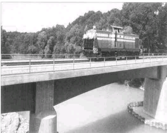
Rys. 12. Most kolejowy z dźwigarów VFT
