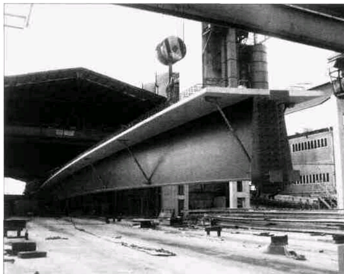
Rys. 6. Wysyłka dźwigarów VFT z wytwórni
