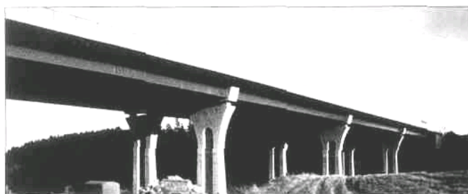
Rys. 3. Estakada nad doliną - dźwigary VFT w układzie ciągłym wieloprzęsto-wym
