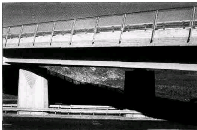
Rys. 3. Estakada nad doliną - dźwigary VFT w układzie ciągłym wieloprzęsto-wym
