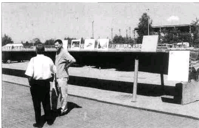
Rys. 16. Pierwszy krajowy dźwigar VFT, przewidziany do zastosowania w moście w Dębicy
