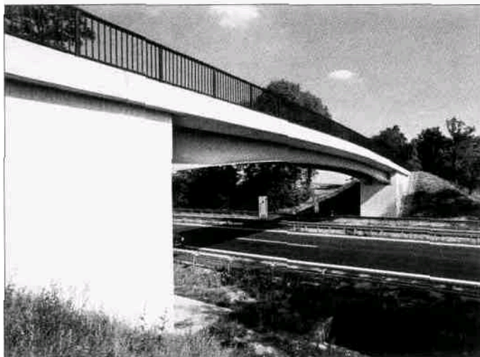
Rys. 2. Kładka ramowa VFT nad autostradą
