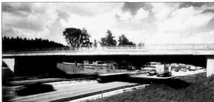
Rys. 1. Wiadukt ramowy VFT nad autostradą
