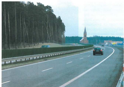
Na górze: budowa nowej drogi – stary pas ruchu był czynny, co było niełatwym wyzwaniem dla drogowców. Na dole: droga S5 i S10 odcinek Stryżek-Białe Błota
